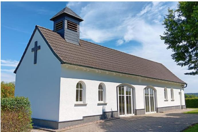
Nachdem die Fassade neu gestrichen und der Sockel mit Natursteinplatten verkleidet wurde, ist die Sanierung unserer Friedhofshalle auf dem Friedhof in Schneckenlohe abgeschlossen.
