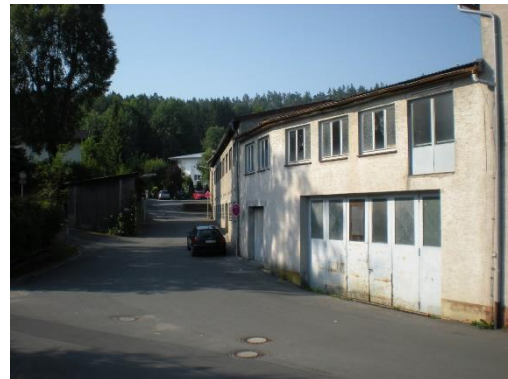
Abb. 89 Gebäude der ehemaligen Fa. Thiele
