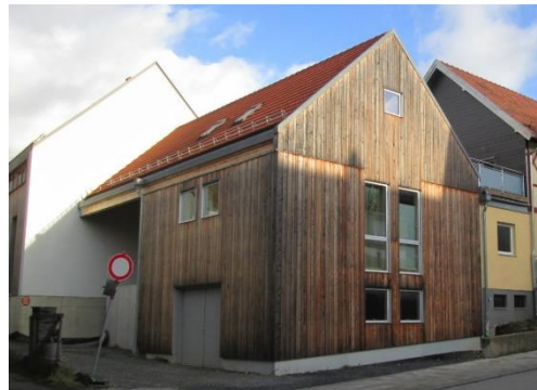
Abb. 66 Anbau Lager ehem. Antiquitätenhandel
