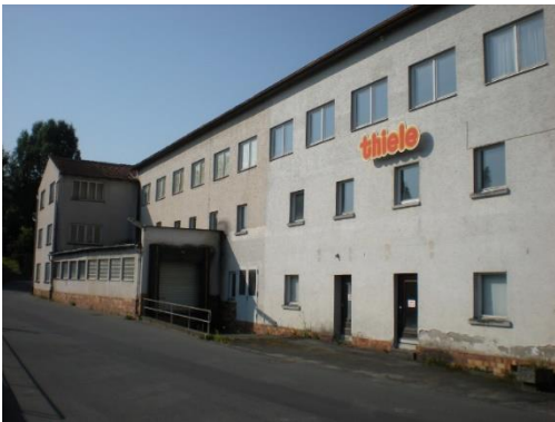
Abb. 88 Gebäude der ehemaligen Fa. Thiele
