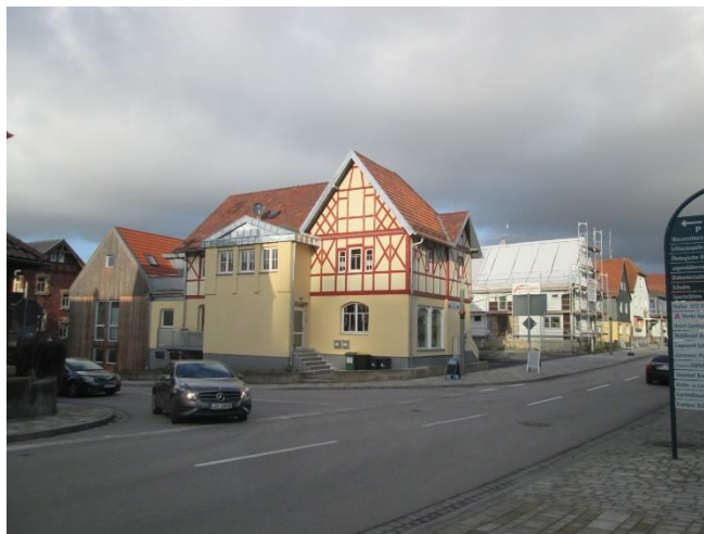
Bsp. Pkt. 4 Unübersichtliche Einmündung
