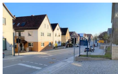
Abb. 65 Neugestaltete Ortsdurchfahrt, Bild Lauer+Lebok Architekten
